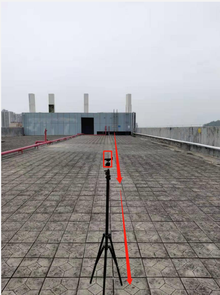
楼顶场测环境
