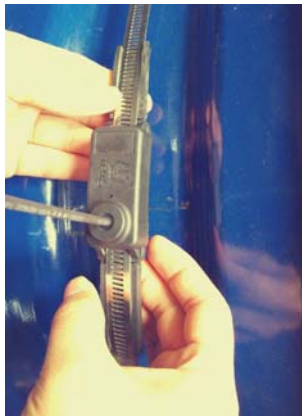
4、 Installing non-slip rubber pad
