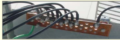
Antenna Buss Bar
