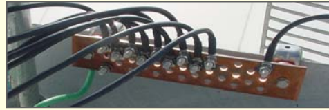
Antenna Buss Bar
