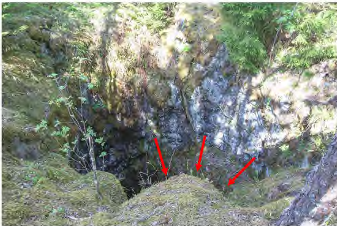
Figur 6. Utstickande avsats ca 9 meter ner i gruvhålet på östra sidan.
