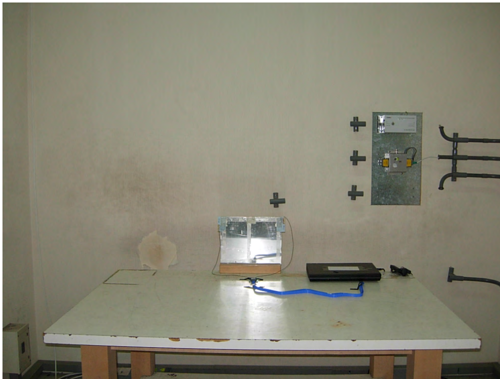
測試相片：電源端點測試 正面相片
